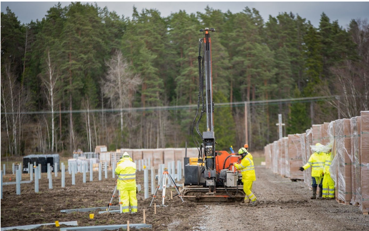
Figur 15-Exempel på pålningsmaskin på larvfötter för installation av pålar för stängsel och markställningar.
