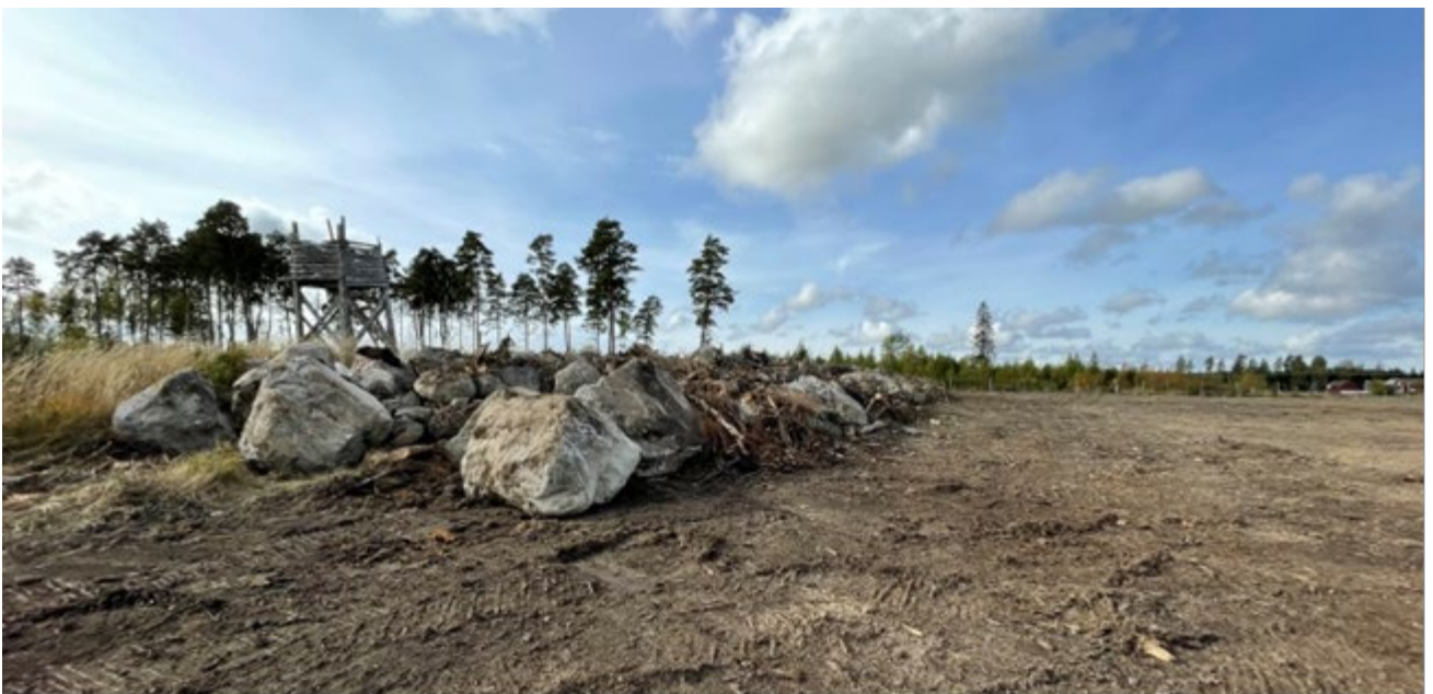
Figur 6-Bild från byggnation av Kungsåra solcellspark utanför Västerås som delvis är uppförd på skogsmark. Här har ett delområde rensats från stubbar och större block samlats ihop.
