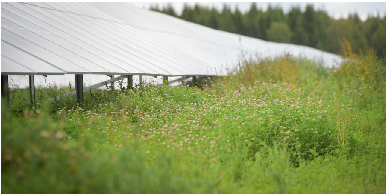
Figur 32 -Exempel på blomning i en solcellspark. Insådd klöver, luddvicker, käringtand med flera arter i Helios Nordic Energys solcellspark i Kungsåra, Västerås.
