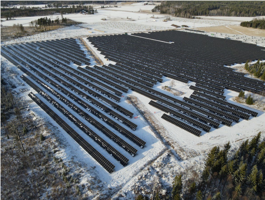
Figur 4. Exempel på byggnation och layout av solcellspark, Kungsåra Västerås februari 2023. Drönarfoto. På bilden framgår tydligt att områden längs diken och runt åkerholmar undvikits som hänsynområden. Delar av området byggdes på skogsmark. I Engaholm kommer diken, naturvärden och kulturmiljöområden att utelämnas.
