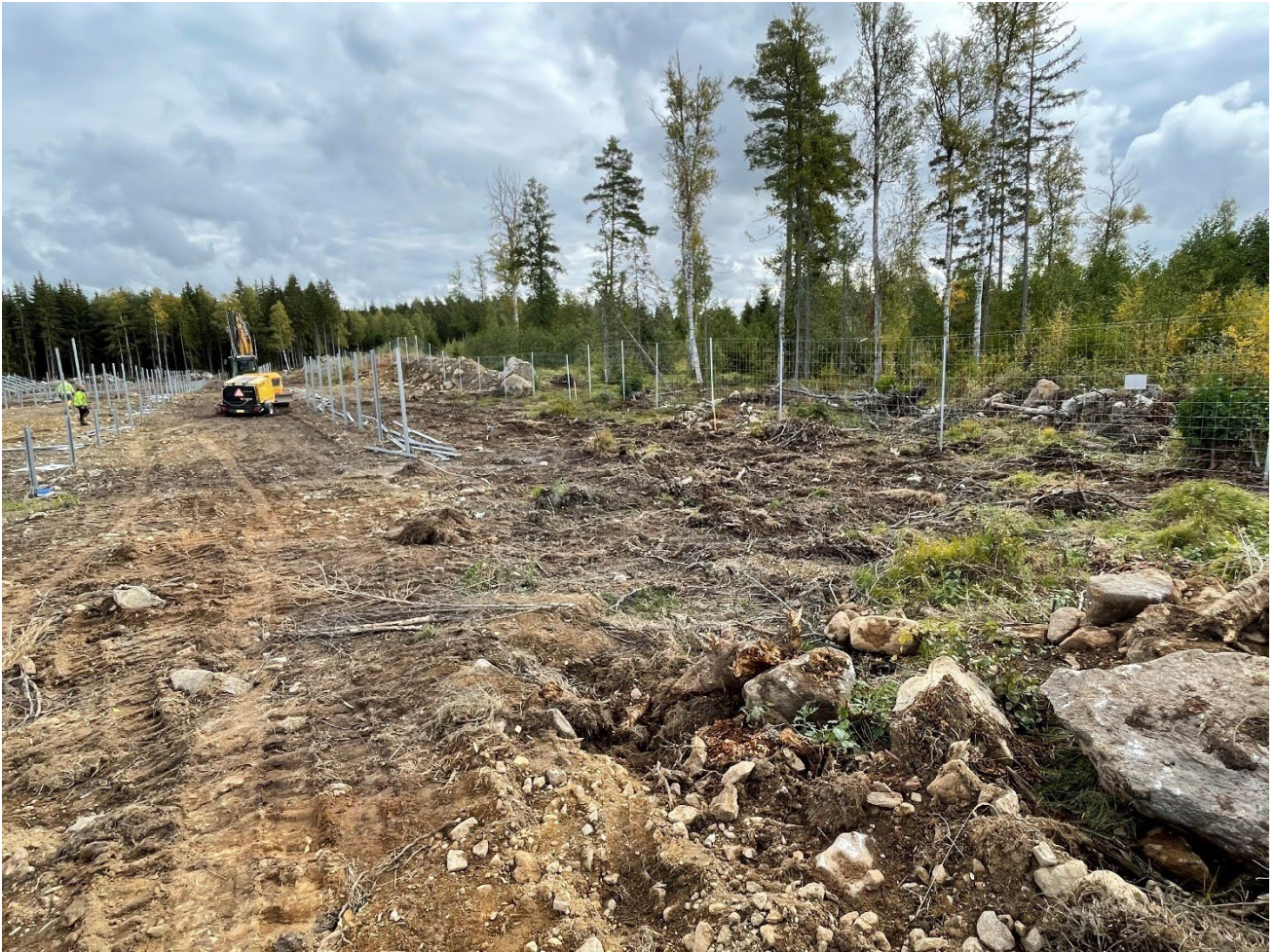
Figur 5 - Bild från byggnation av Kungsåra solcellspark utanför Västerås som delvis är uppförd på skogsmark. Stängsel har satts upp och arbete med pålar/stålprofiler pågår på bilden.
