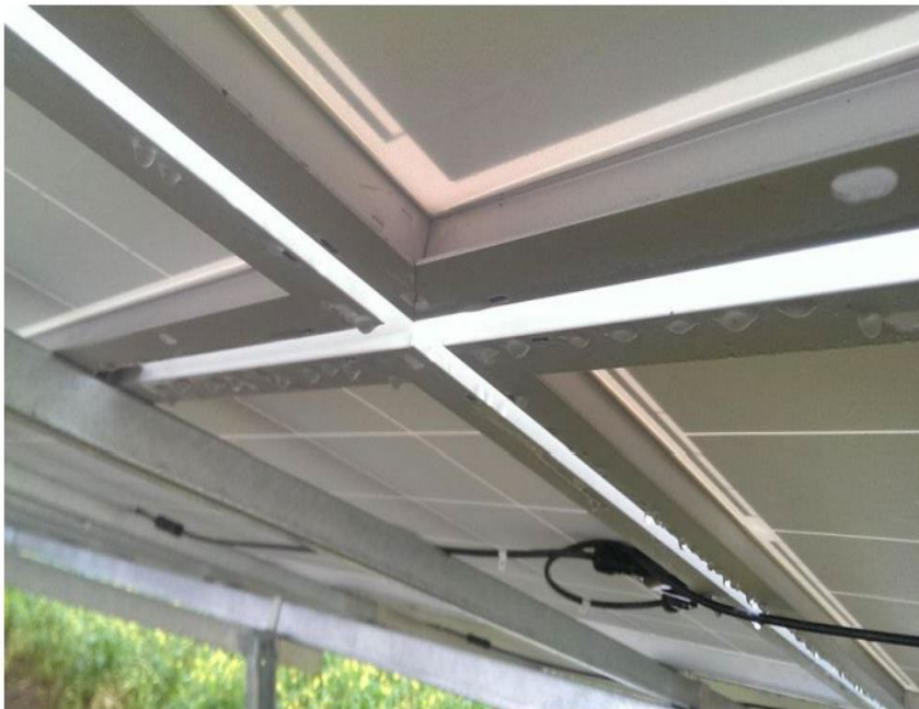
Figur 45. Fotodetalj under solcellsrad som visar mellanrum genom vilka vatten kan rinna.
