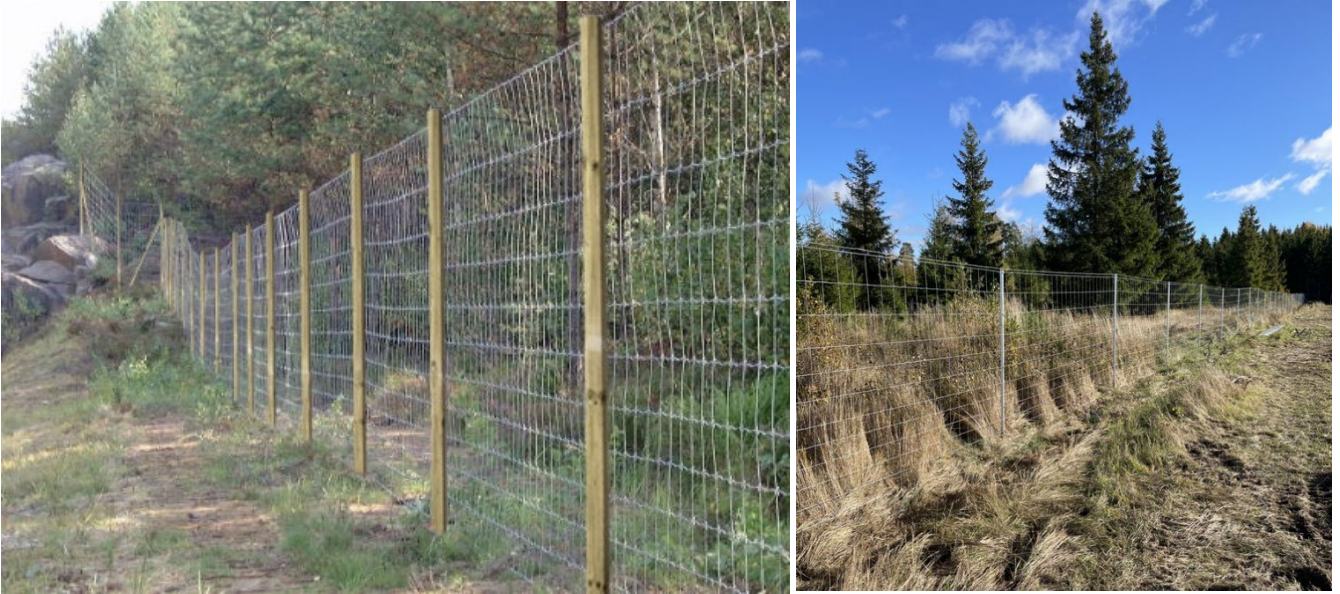
Figur 8-Exempel på utförande av stängsel, viltstängsel på trästolpar till vänster och stålstolpar till höger.
