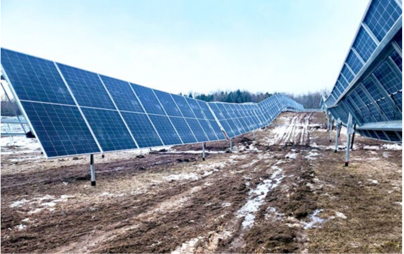
Figur 14-Exempel på solceller i något kuperad mark Solcellsmodulernas sektioner används för att ta upp höjdvariationer. En solcellspark i skogsmark med höjdvariationer kommer att bölja över området.
